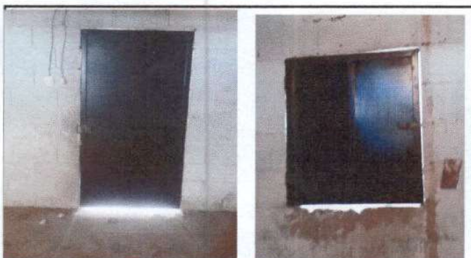
Foto 4: sustitución de puertas y estructura de ventanas en cocina, biblioteca y bodega.
