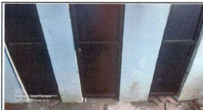
Foto 3: sustitucion de puerta en servicios sanitarios.
