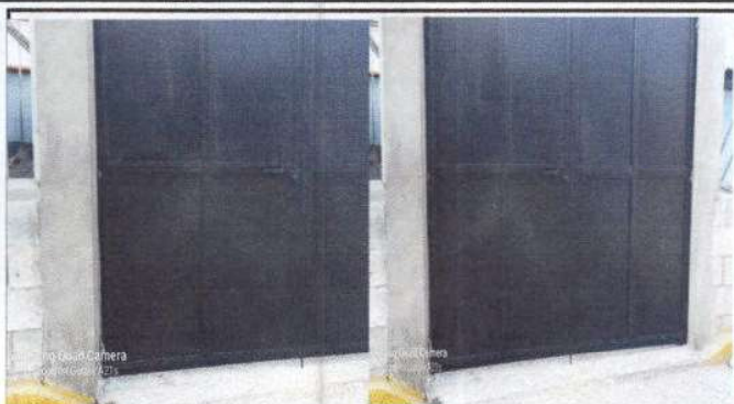
Foto 2: sustitución de portón de metal por metal.
